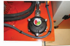
Çift Yağ Filtresi Emiş ve Dönüş Yağ Kirlilik Göstergesi
